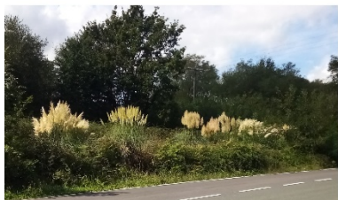
Gasoducto (2021-9-24), sin desbrozar a tiempo.
